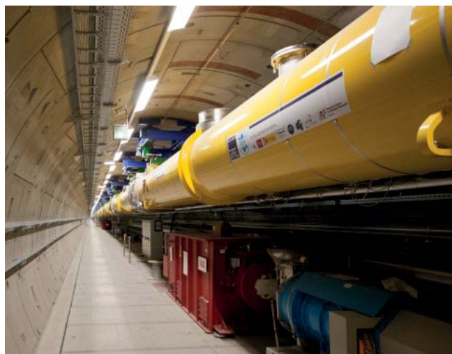
Bild 3: Del av den 1,7 km långa accelerator-tunneln vid European XFEL.
