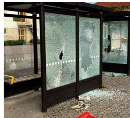
FIGUR 3 Härdat glas som spräckts, kanske med en stulen hammare.
