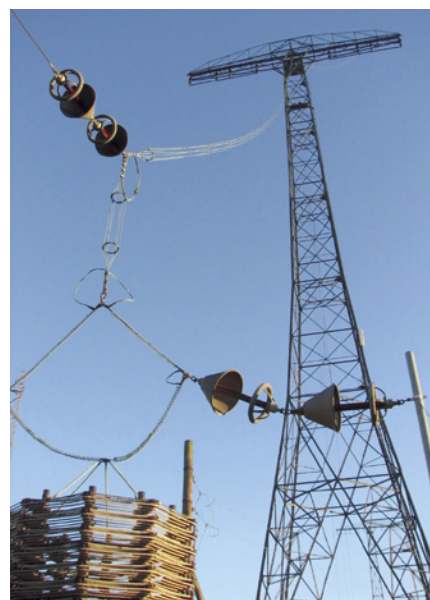
FIGUR 3 Ett torn med sin vertikala antenneledning kopplad till spolen.
