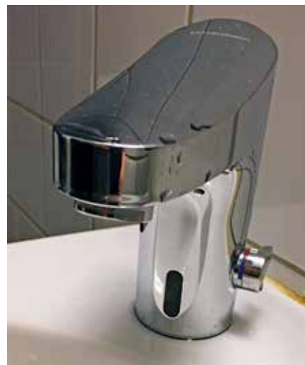
FIGUR 6 Beröringsfri blandare där sensorn (svart) sitter nedtill och temperaturvredet till höger.
