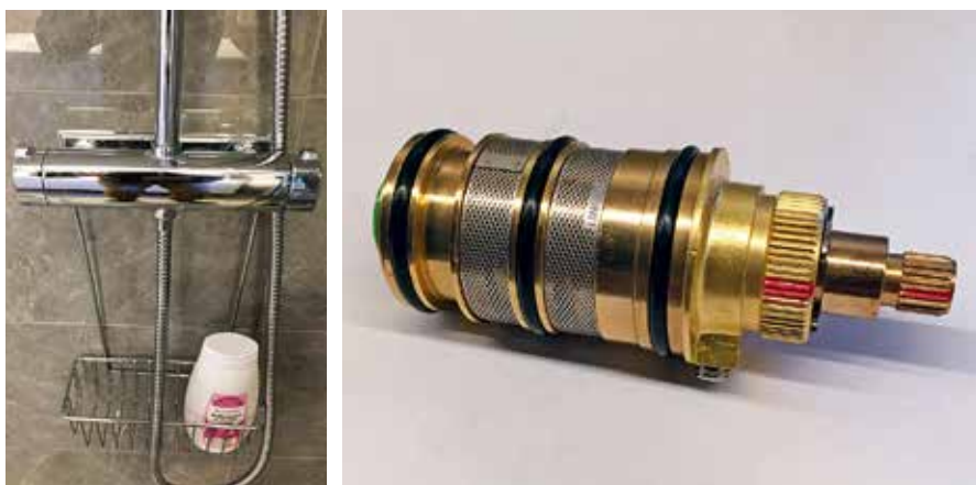
FIGUR 3 Termostatblandare där flödet regleras till vänster och temperaturen till höger. Till höger termostatpatronen som, när dess två röda markeringar syns i linje, är inställd på 38 °C. Vattnet kommer in genom de två silverfärgade filtren och temperaturen väljs till höger, när temperaturvredet satts på.
