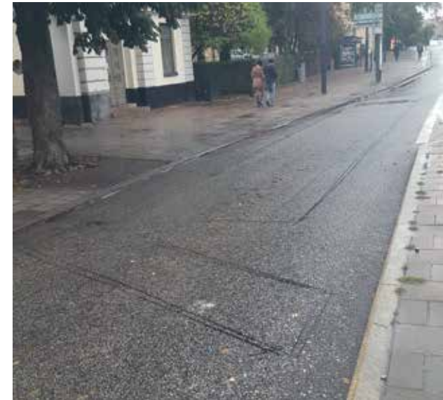
Figur 2: En lång rektangulär närvaroslinga samt en 45 graders passageslinga.
