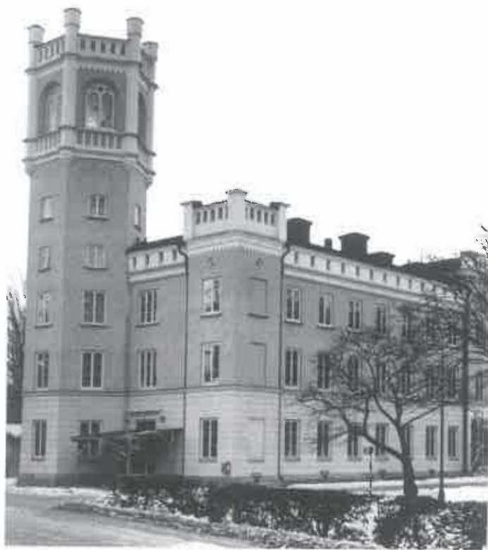
Figur 2. Institutionsbyggnad (Kemikum) vid Engelska parken, uppförd i slutet av 1850-talet för kemi, medicinsk kemi, mineralogi/geologi samt fysiskt kabinett. Bilden visar endast den södra tredjedelen av byggnaden, den del där Anders Jonas Ångström från år 1858 i översta våningen samt tornet gjorde sina banbrytande spektroskopiska arbeten. Under hans tid låg professors bostad i den centrala delen, medan den norra tredjedelen disponerades av mineralogi/geologi. Sedan kemin år 1904 fick en ny institution kallades byggnaden »Gamla Kemikum». Foto univ.bibl.
