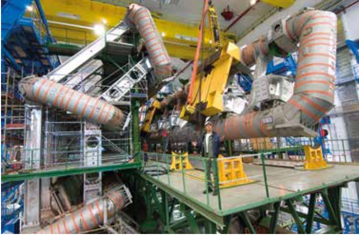
Figur 5: Den åttonde och sista centrala toroidspolen installeras i ATLAS-detektorn. De tubformade strukturerna med orange tejp är kryostater som innehåller varsin supraledande spole (foto CERN).
