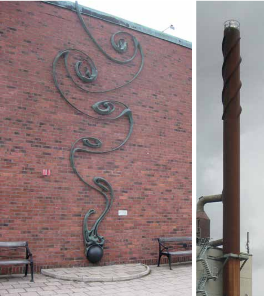
Olov Tällströms konstverk på KTH visar von Kármán-virvlar. Att cylindern ersatts med ett klot är ”konstnärlig frihet”. Skorstenen i närheten har spiralband för att förhindra att von Kármán-virvlar sätter den i resonanssvängning. (Foton: Göran Grimvall)
