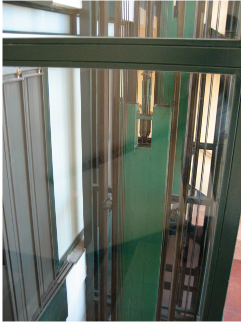
Bilden till vänster visar en grönmålad motvikt inuti ett hisschakt på med glasväggar. Till höger en schematisk bild av en hiss med motvikt.
