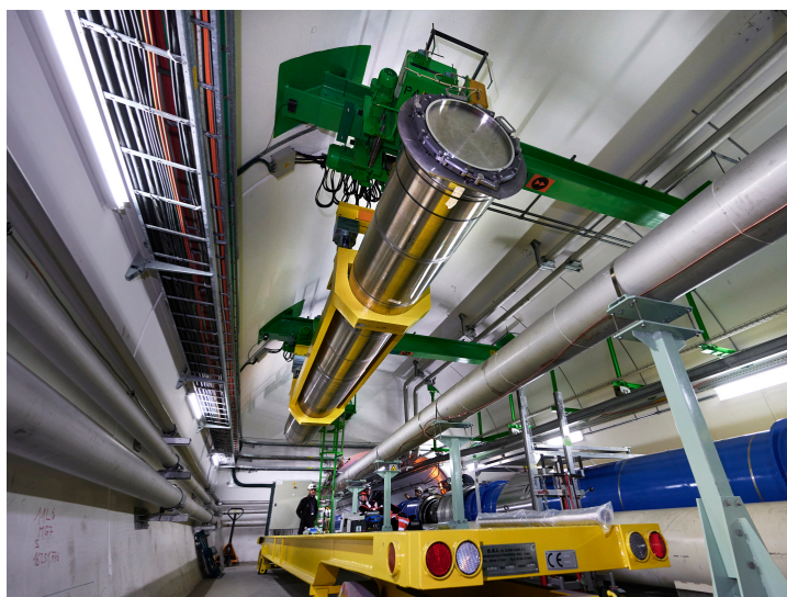
I början av 2020 uppgaderades strål-dump-systemet vid LHC. Bildkälla: CERN (bild tagen från https://home.cern/news/news/accelerators/l2-report-consolidation-lhcs-external-beam-dumps )
