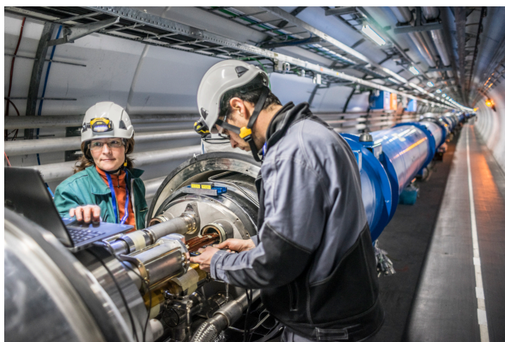
Underhållsarbete vid LHC. Bildkälla: CERN (bild tagen från https://home.cern/science/accelerators/large-hadron-collider )
